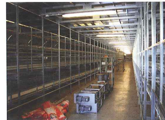
In de tweede twee-etagestal wordt gewerkt aan de inrichting. Die moet eind mei klaar zijn
