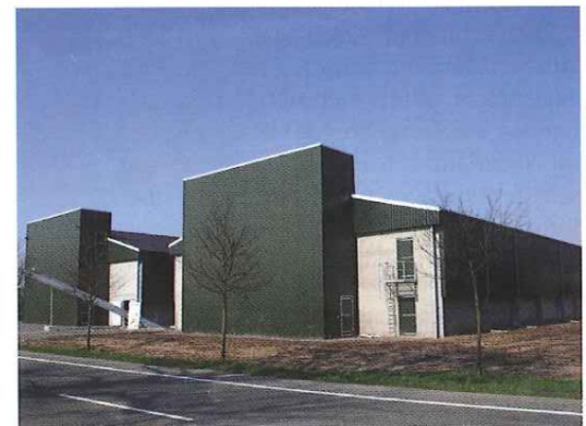
Aan de achterkant zitten bij elke stal 16 luchtafvoerkanalen. Achter een ombouw voor het zicht
